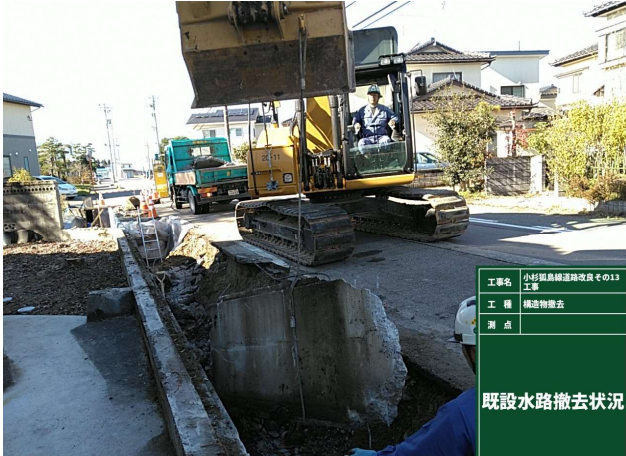
既設水路撤去
