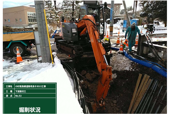
下流取付工(掘削)
