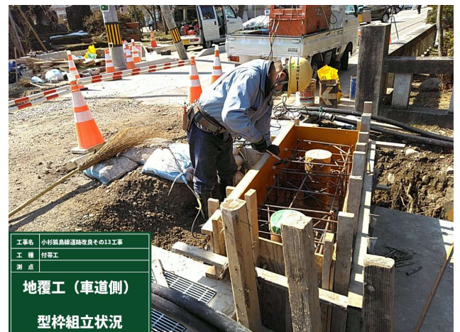
付帯工(地覆工(車道側)型枠組立)
