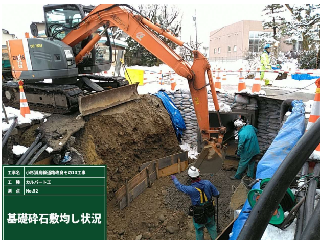
ガルバート工(基礎碎石敷均し)
